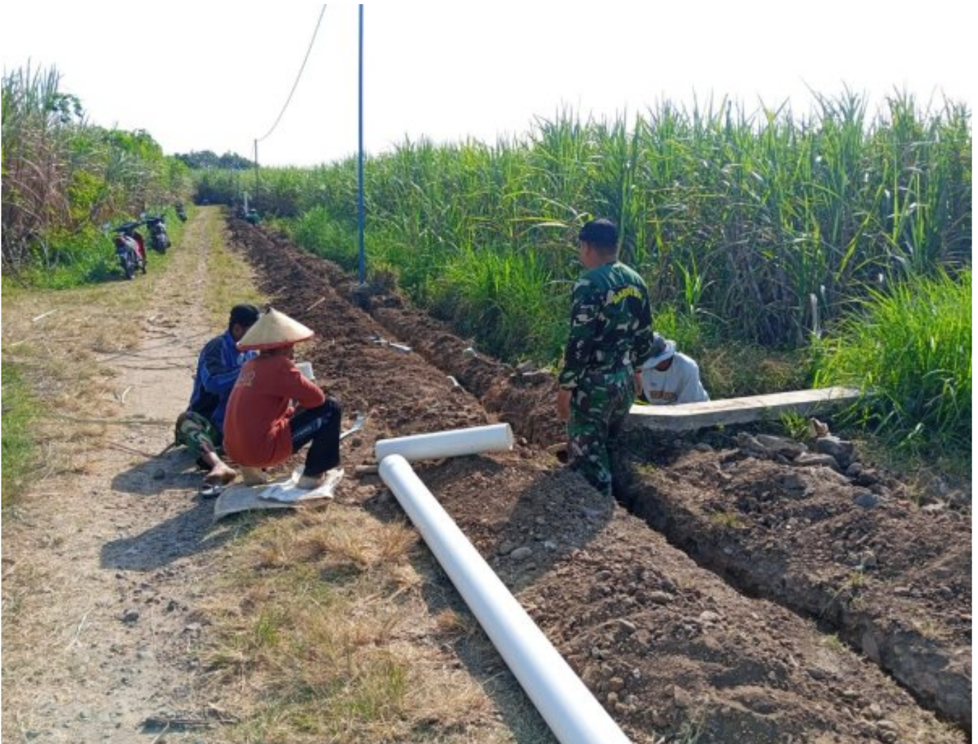
Babinsa Koramil 0804/ 13 Bendo Dampingi Pemasangan Pipa Air Wujud Nyata Dukung Swasembada Pangan
